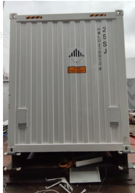
储能集装箱侧面外观 (含9类标签, UN号, 正确运输名称)
